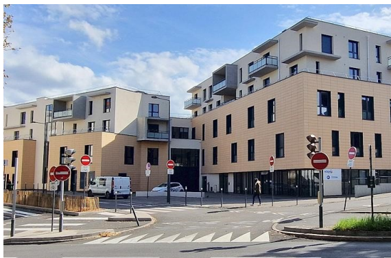
À Saint-Etienne, Bâtir et Loger, la filiale dédiée à l'habitat social locatif de la CIFV, a livré en 2022 un foyer ADAPEI, reconstruit dans une ancienne école de la ville, boulevard Jules Janin, proche de la place Carnot. Le projet dit du « Treyve » a mobilisé près de 7 millions d'euros de travaux. Photo transmise par la CIFV
